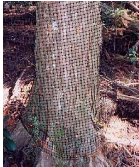
写真 - 9 バークガード設置状況
