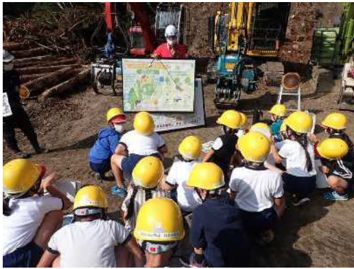
【伐採現場見学】
