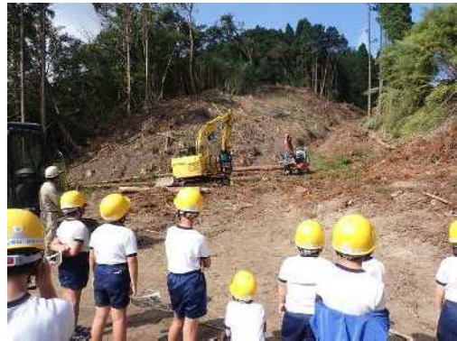
【伐採現場見学】
